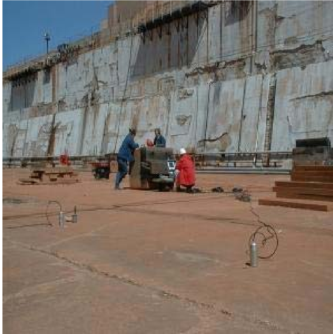
Kuru Havuzda SASW
